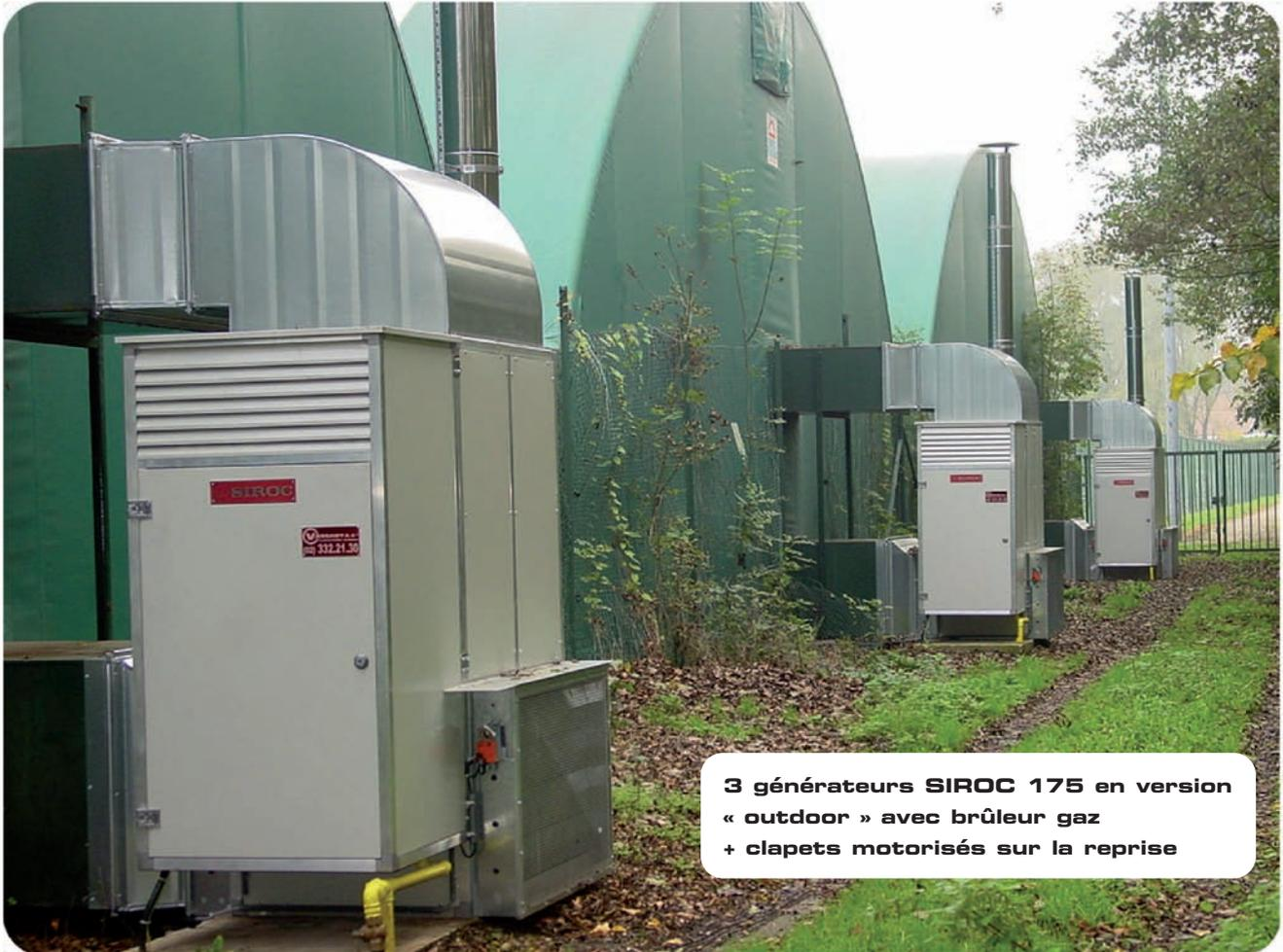
**3 générateurs SIROC 175 en version « outdoor » avec brûleur gaz + clapets motorisés sur la reprise**
